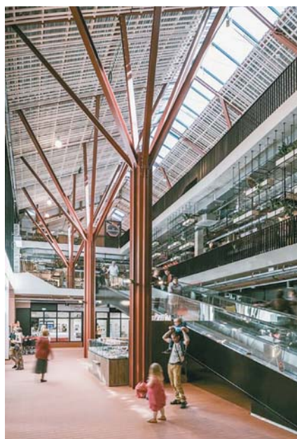
► (b) Pilar árvore simplificado de aço
