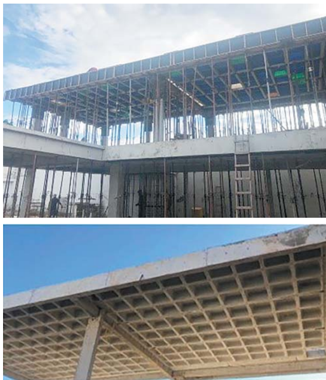
Laje Nervurada bidirecional após desmontagem dos moldes e cimbração
