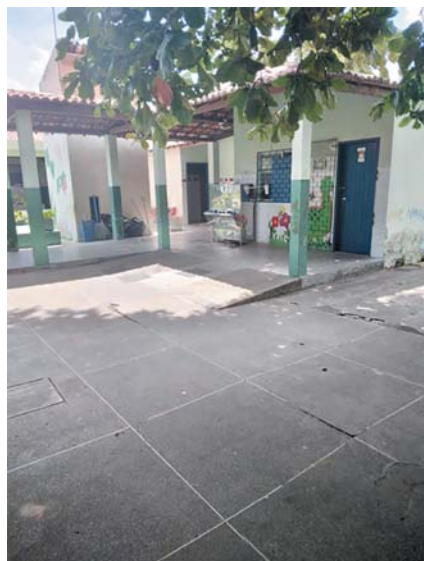
Figura 1 - Estrutura da Escola
